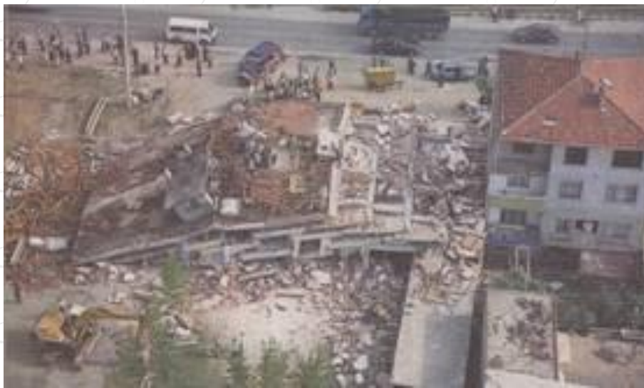
نمونه ای از خرابی ساختمان بصورت پن کیک در زلزله ۱۹۹۹ ایزمیت
